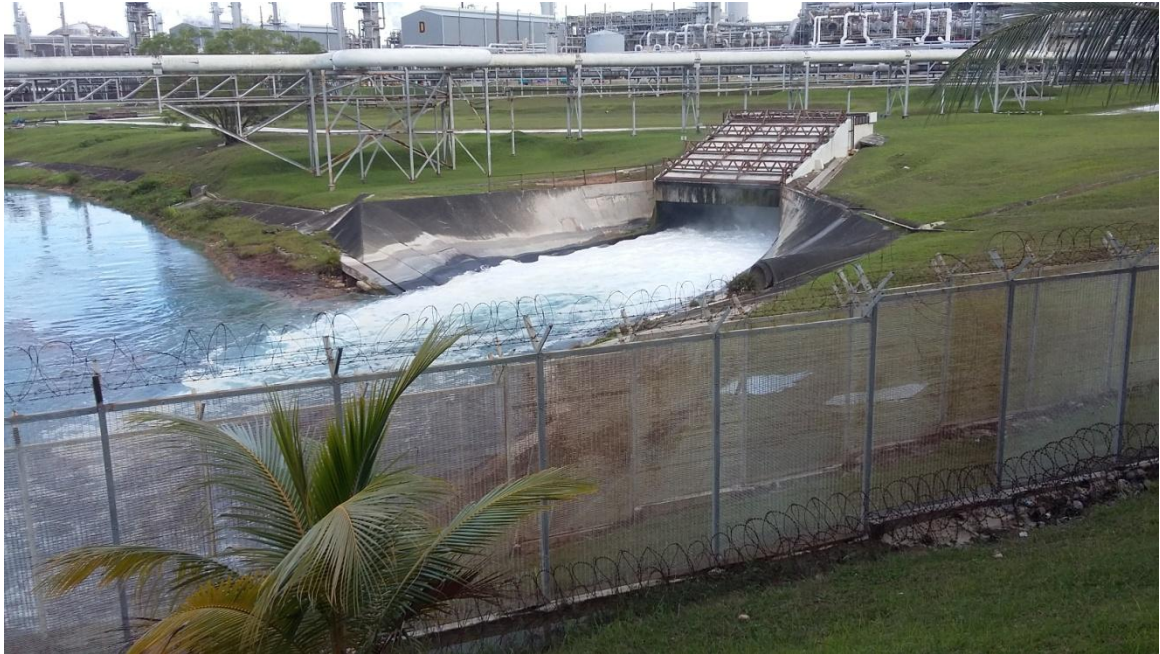
Gambar 1. Outfall Kanal Train E-F
