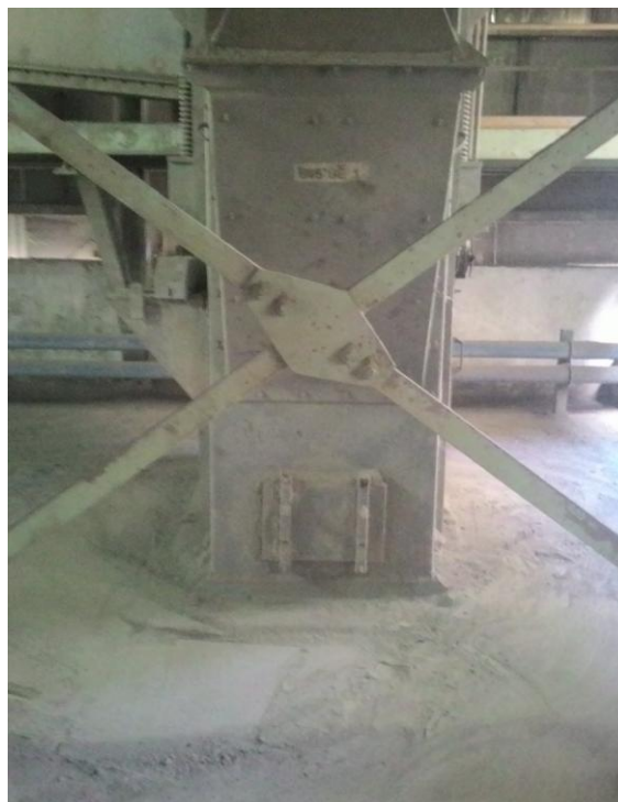
Gambar 5 Bottom bucket elevator saat tidak terjadi overflow
