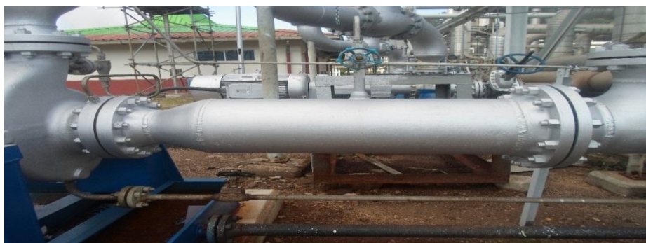
Gambar 6. Pipa yang Sudah diperbaiki
