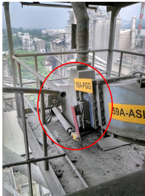
Gambar 10. Proportional gate setelah perbaikan.
