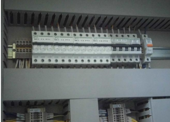
Gambar 5. Pemasangan komponen Panel
